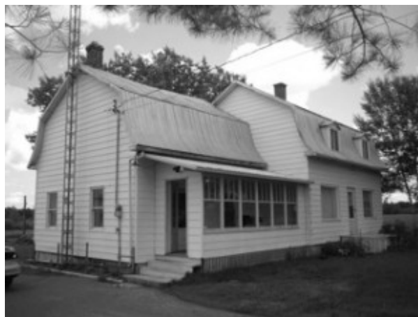
Maison Victor-Dubois avant sa restauration. Photo : Christian Chartier.
